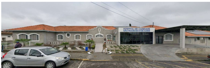
Foto 01: Vista Frontal da edificação: Rua Cel. Hortêncio Martins de Melo, 78
