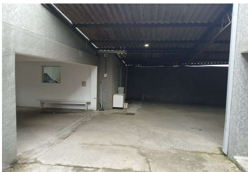
Fotos 06, 07, 08 e 09: Vista fundos terreno - áreas a serem ampliadas
